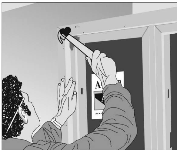
Рис. 6.40. Фиксация обойными гвоздями длиной 3\frac{1}{2} дюйма одного угла окна через верхний наличник (Andersen)
