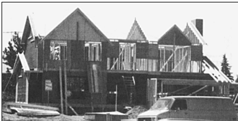
Рис. 4.99. Возведение стен дома
