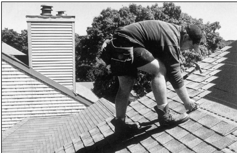
Рис. 5.36. Рабочий, укладывающий листы рубероидной плитки
