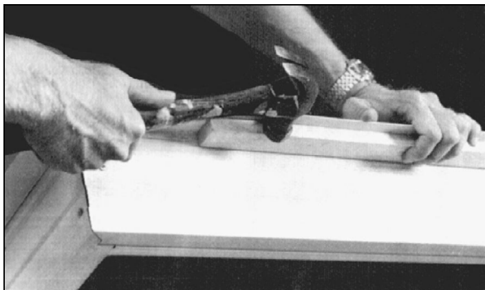
Рис. 6.153. Начало установки раздвижной двери модели Perma-Shield®: а — положение винилового отлива после установки (Andersen); б — использование деревянного бруска для установки винилового отлива (Andersen)
