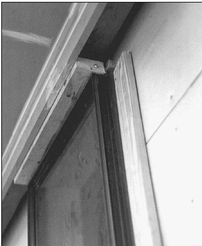
Рис. 7.3. Оконный блок изолирован для устройства кирпичной облицовки
