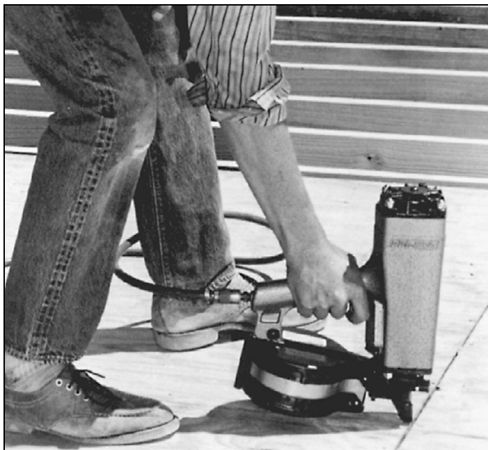
Рис. 2.45. Использование высокопроизводительного гвоздезабивателя экономит время и силы (Duo-Fast)
