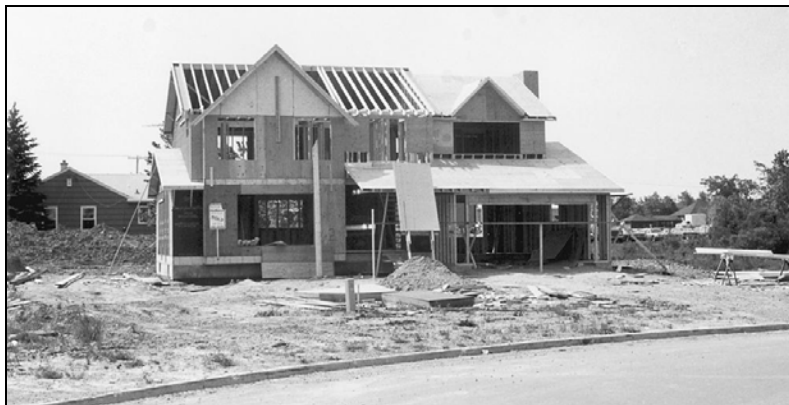
Рис. 4.100. Обшивка из фанеры, установленная на одной части стропил. Используется приставная лестница, которая предназначена для подъема листов фанеры
