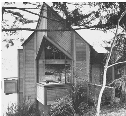
Рис. 7.2. Разновидности сайдинга: а — кедровые доски, использованные разнонаправленно для этого типа обшивки (Potlatch); б — сайдинг из фанеры в форме досок (American Plywood Association); в — сайдинг, сочетающий грубую отделку кирпичом, гладкую штукатурку и доски; г — сайдинг из камня, использованный для облицовки рамной конструкции
