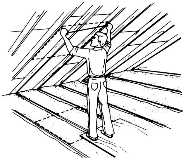
Рис. 6.53. Измерение проема для светового люка
