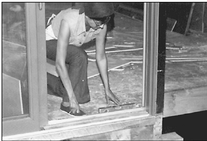
Рис. 6.137. Установка порога по уровню
