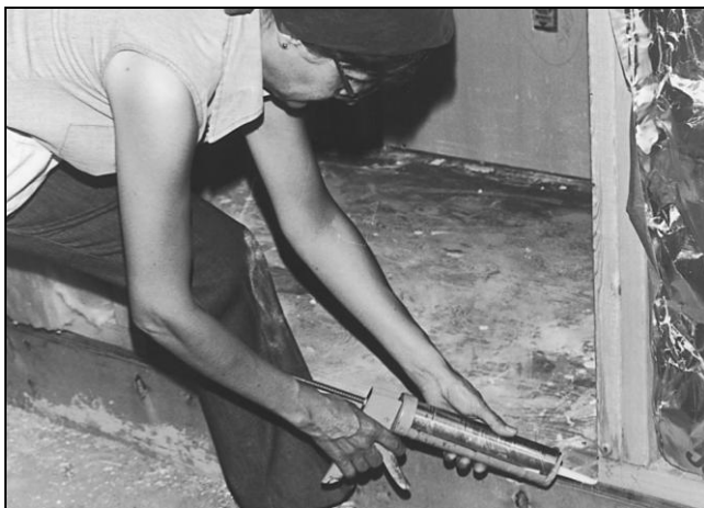
Рис. 6.136. Герметизация порога и периметра раздвижной двери
