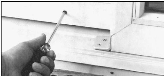
Рис. 6.148. Регулировка прямоугольной формы двери (Andersen)
