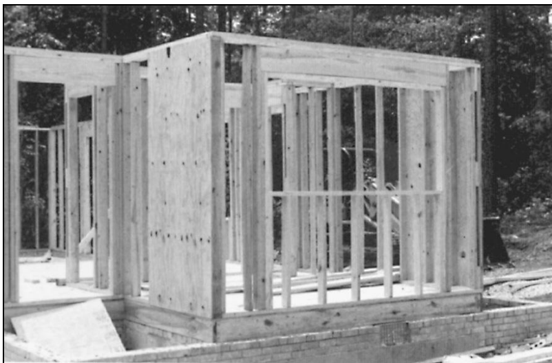
Рис. 3.1. Стеновой каркас устанавливается после завершения устройства пола
