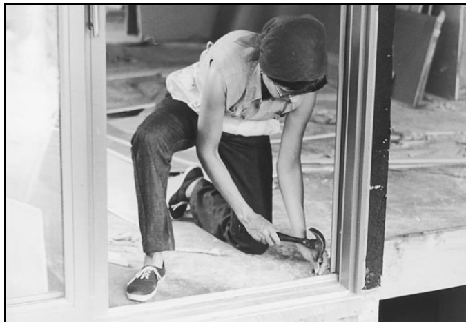
Рис. 6.138. Крепление обвязки к полу гвоздями
