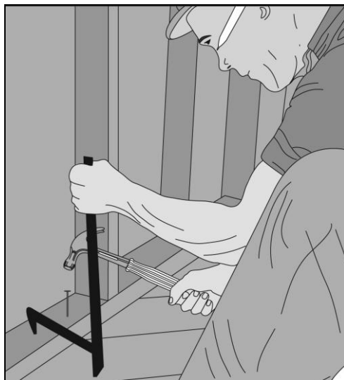
Рис. 3.40. Крепление установленной стены гвоздями к черновому полу (Proctor Products)
