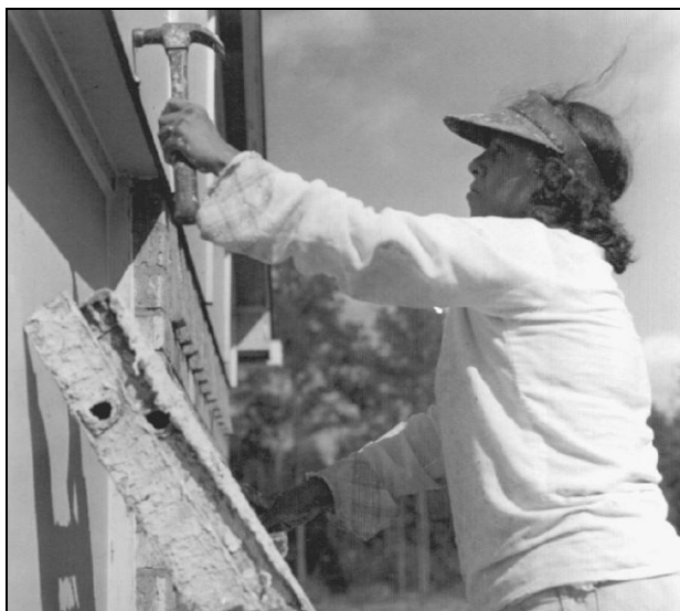
Рис. 7.39. Устройство сайдинга фронтона (Fox and Jacobs)
