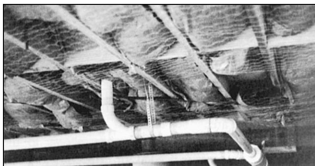
Рис. 2.60. Устройство теплоизоляции на специальных опорах
