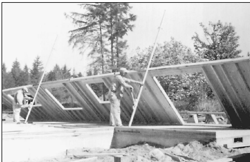
Рис. 3.35. Подъем стены с помощью лебедок (Proctor Products)
