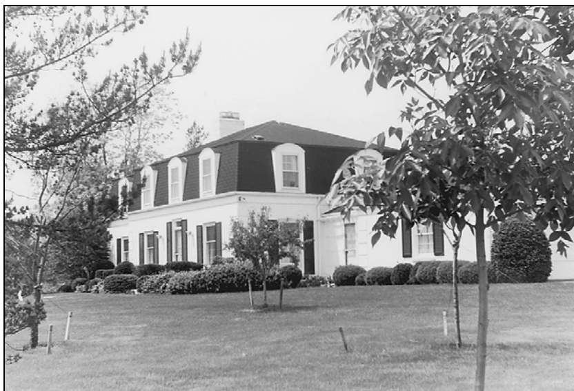
Рис. 6.48. Окна — важная часть архитектурного облика дома
