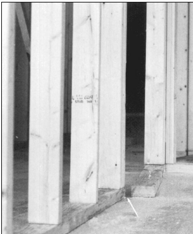
Рис. 3.44. Дверные проемы: нижние брусья обвязки внутренних перегородок разрезаются после установки
