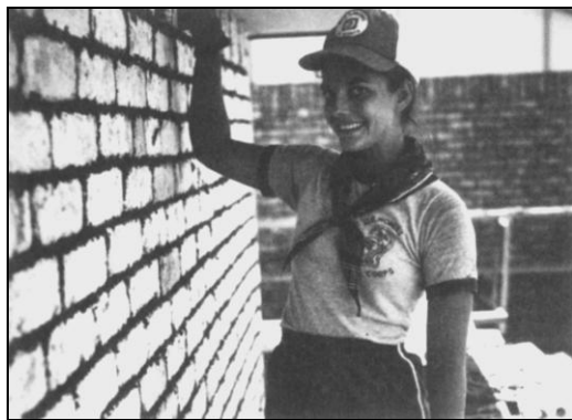
Рис. 7.66. После укладки кирпичей швы зачищаются или отделываются (Fox and Jacobs)
