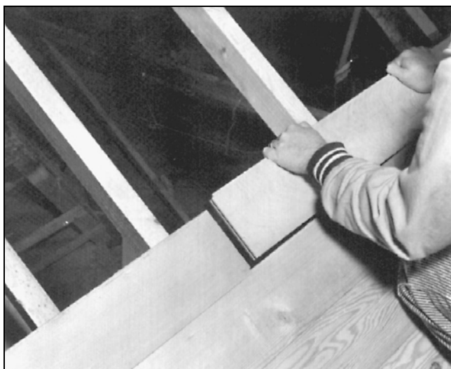
Рис. 2.51. Шпунтованная доска укладывается перпендикулярно лагам, а стыки можно выполнять в любом месте
