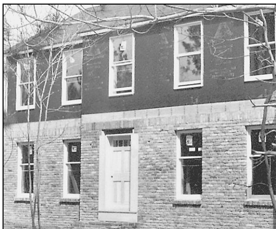
Рис. 6.14. Подъемные окна с двумя вертикальными раздвижными створками в стене с кирпичной облицовкой (нижний этаж) и группа раздвижных окон (верхний этаж)
