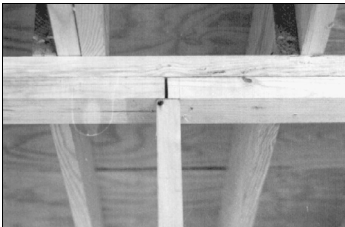
Рис. 3.5. Соединение бруса верхней обвязки над стойкой
