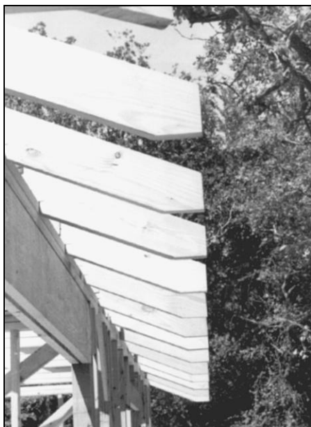
Рис. 1.24. Свесы стропил с концами, отпиленными под одним углом
