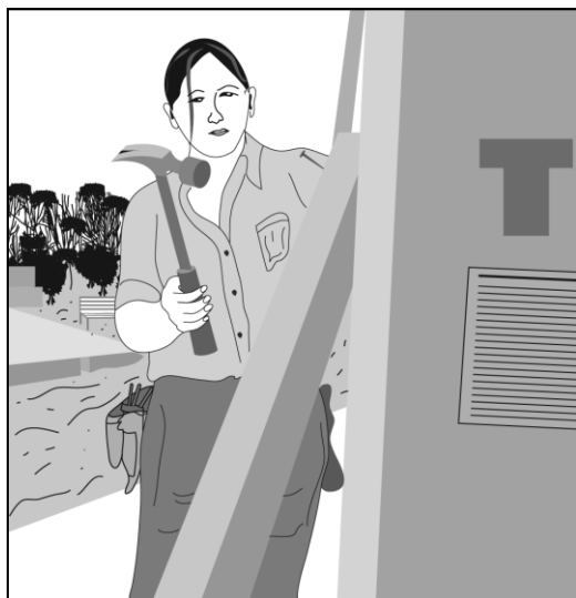
Рис. 3.39. Крепление гвоздями временных подпорок (Fox and Jacobs)
