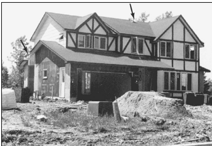
Рис. 4.92. Стрелка показывает место проема в крыше для вывода дымохода
