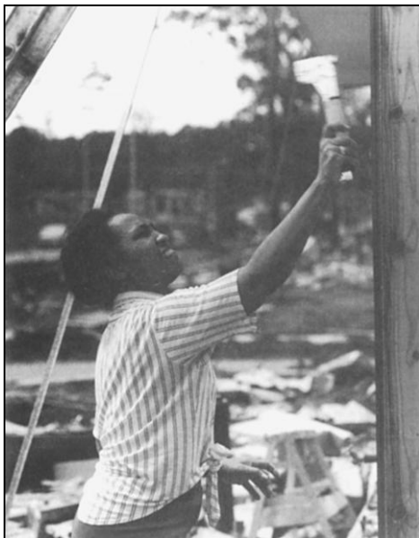
Рис. 7.55. Панельный сайдинг часто крепится скобами (Fox and Jacobs)
