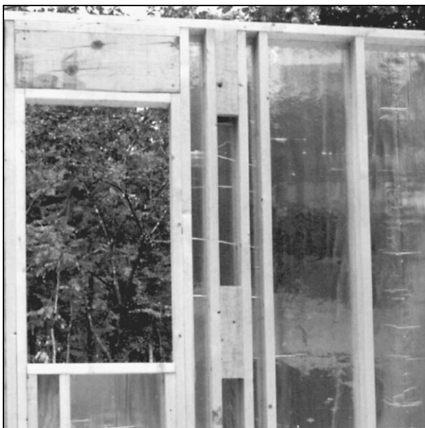
Рис. 3.17. Короткие стойки могут быть использованы как под торцевой доской, так и под нижней обвязкой проема
