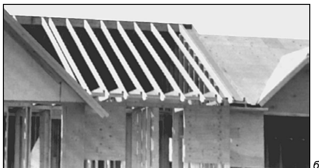
Рис. 4.39. а — разрезы пилой за «клювом птицы»; б — стропила установлены на место. Они крепятся гвоздями к коньковому брусу и потолочным балкам. Другая сторона крыши уже покрыта фанерной обшивкой
