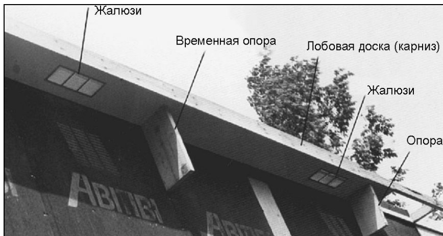
Рис. 4.101. Временные опоры поддерживают софит с жалюзи
