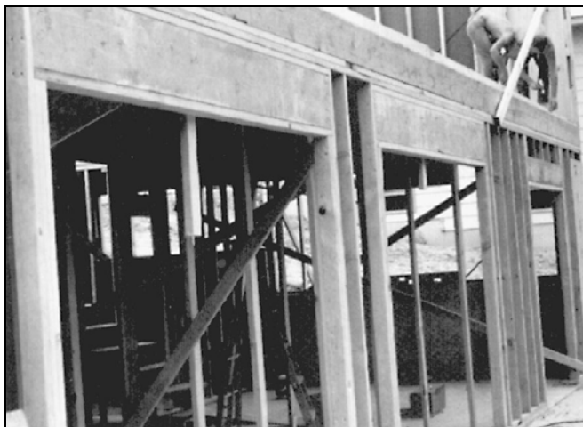
Рис. 3.16. При использовании сплошных торцевых досок отпадает необходимость установки коротких стоек
