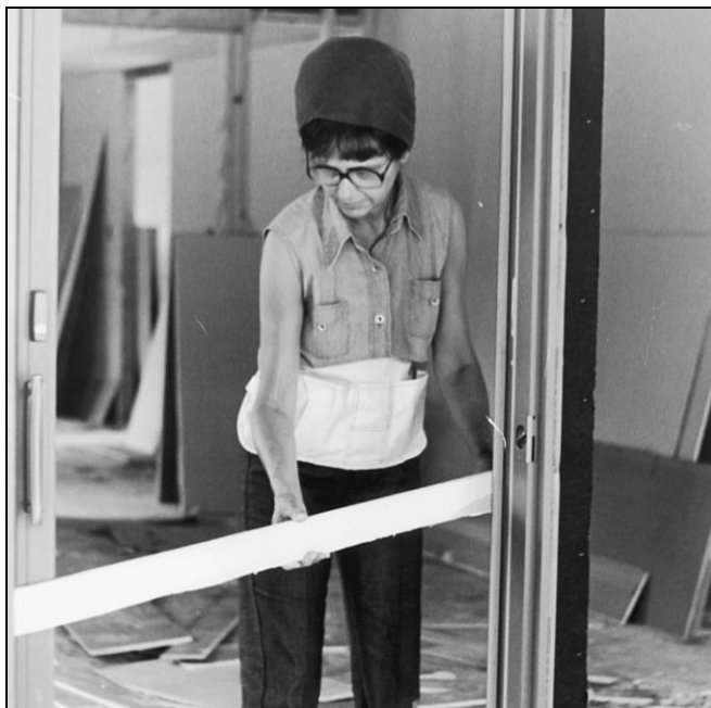
Рис. 6.142. Установка стационарной дверной панели во внешней направляющей с помощью клина размером 3×4 дюйма
