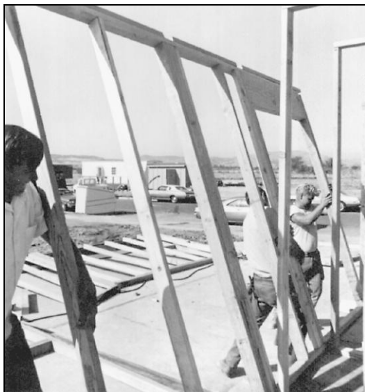
Рис. 3.34. Подъем стеновой секции вручную (American Plywood Association)
