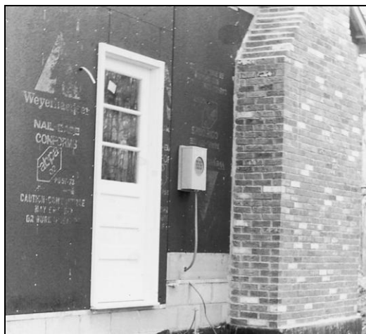
Рис. 6.76. Входная дверь с тремя стеклянными панелями, изготовленная на фабрике. Следует обратить внимание, что отделка двери выступает настолько, чтобы обшивку дома можно было установить встык к ней
