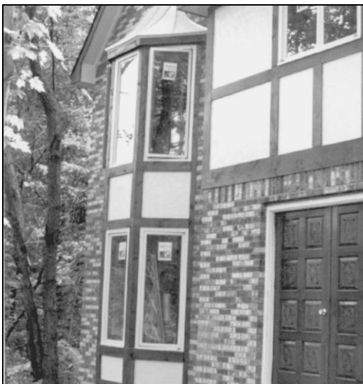
Рис. 2.52. Виды эркеров: а — нависающий эркер, опирающийся на удлиненные половые лаги второго этажа (American Plywood Association); б — эркер на всю высоту здания, опирающийся на консольные системы половых балок этажей
