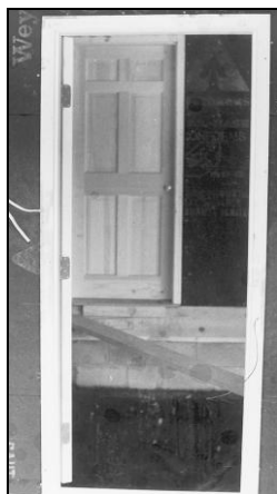
Рис. 6.84. Сборка дверного блока (слева направо)
