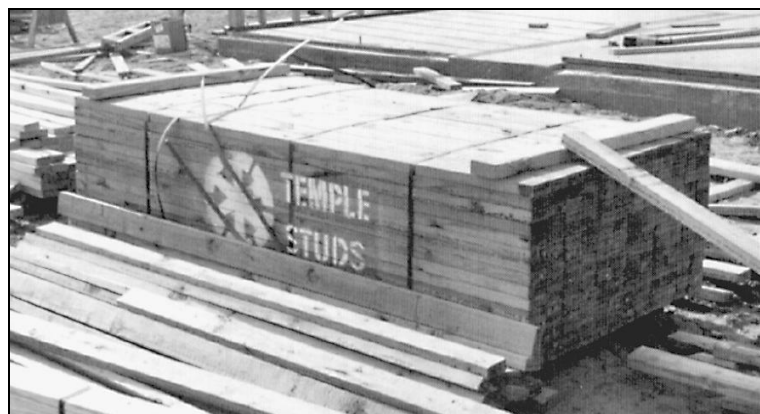
Рис. 3.15. Полуфабрикаты стоек, готовые к использованию на строительной площадке
