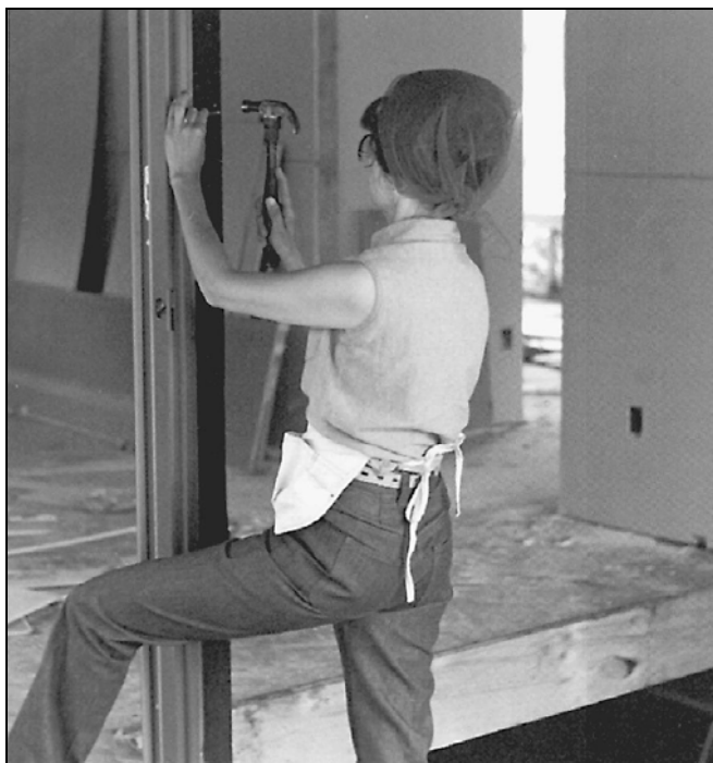
Рис. 6.140. Фиксация отлива на верхнем наличнике с помощью гвоздей
