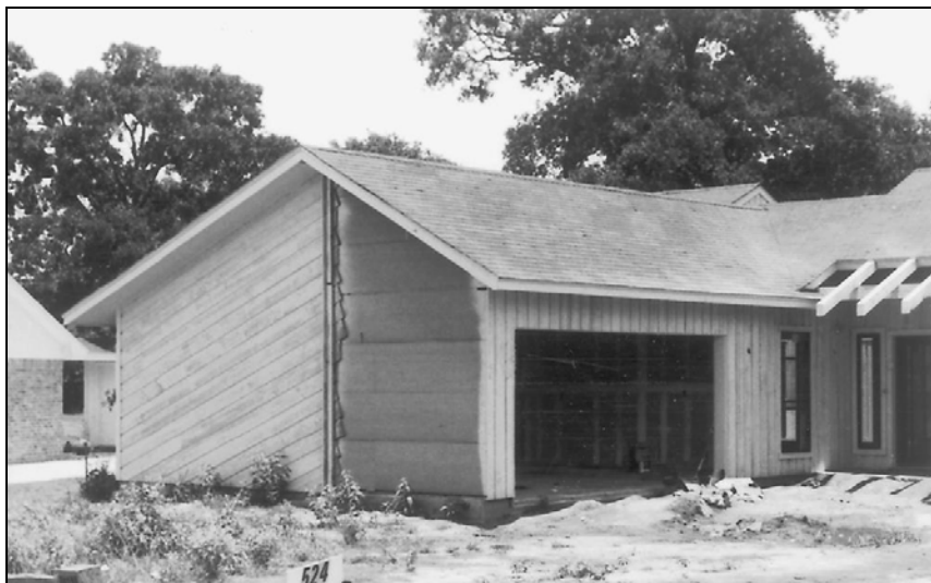
Рис. 7.33. Стена и фронтон подготовлены для устройства комбинации из диагонального сайдинга и отделки кирпичом. Следует обратить внимание, что дерево было окрашено до устройства кирпичной облицовки
