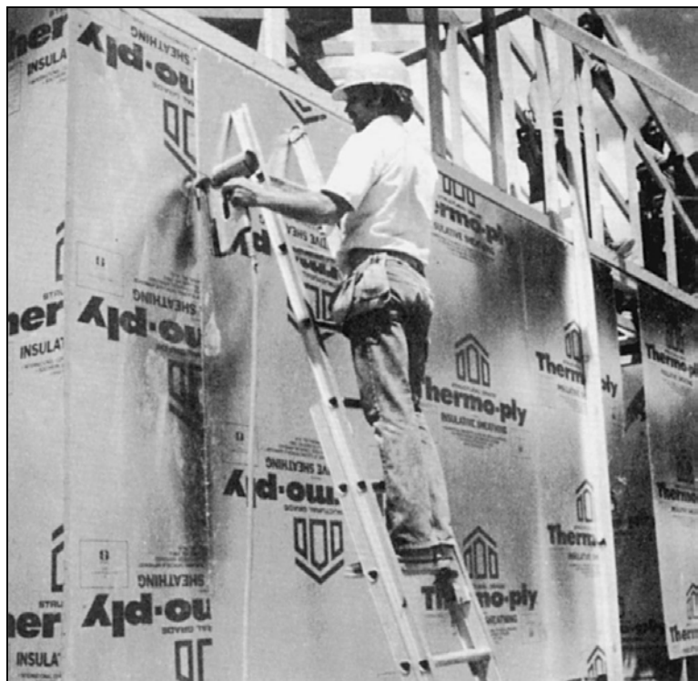
Рис. 3.57. Другой способ обшивки с эффективной теплоизоляцией аналогичен использованию ДВП, но с покрытием отражающей фольгой (Simplex)
