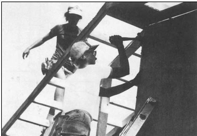
Рис. 4.73. Лицевая обшивка фронтонов, обшивка софитами карнизных и фронтовых свесов крыши могут быть выполнены одновременно (Fox and Jacobs)
