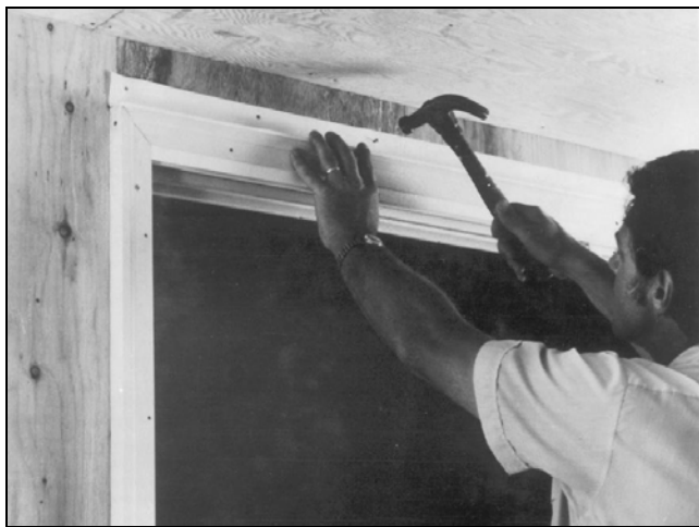
Рис. 6.139. Крепление блока гвоздями снаружи (Andersen)
