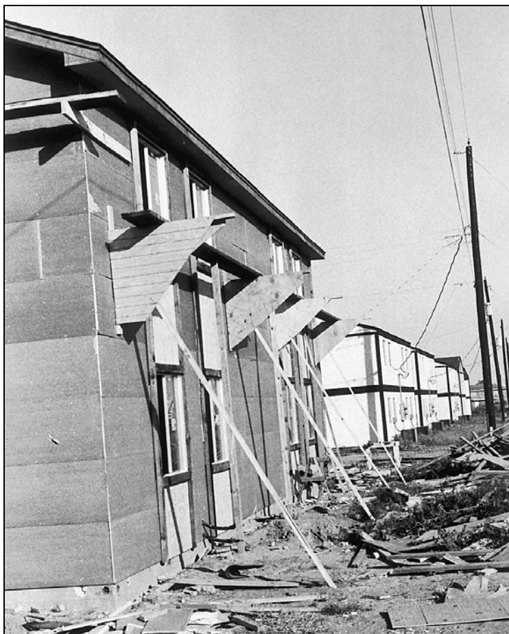
Рис. 7.12. Изготовленные на месте леса на ственных кронштейнах. Очень опасно работать на лесах такого рода на большой высоте без средств безопасности
