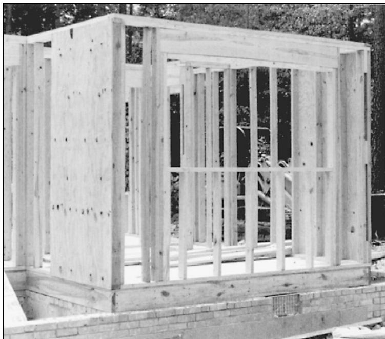
Рис. 3.32. Лист фанеры использован для жесткости конструкции
