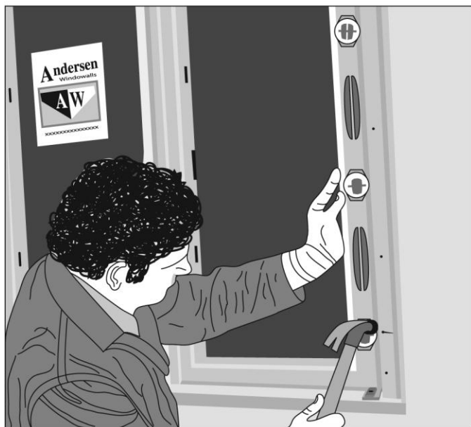
Рис. 6.42. Проверить вертикальное положение и прибить нижний угол
