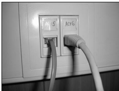
**Рис. 1.5.** Телефонный и компьютерный кабели подключены в одинаковые гнезда
