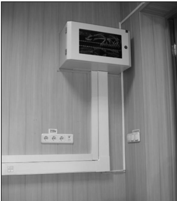
Рис. 1.3. Нормальная коммутация кабелей и размещение оборудования
