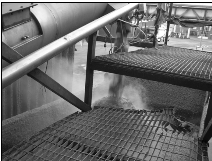
Рис. 4.8. Пивоваренный завод «Балтика-Петербург» — цех отпуска дробины, сброс в кузов
