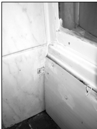
Рис. 2.2. Монтаж уголка по периметру кабинки
