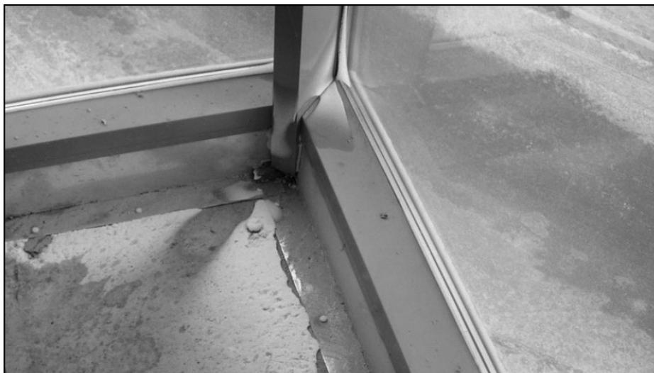
Рис. 3.9. Результат установки стеклопакета с нарушением технологии
