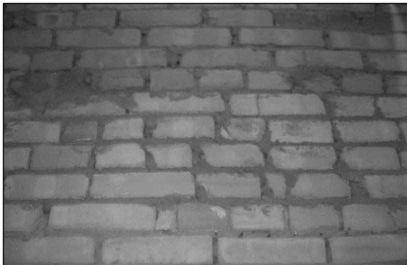
Рис. 2.18. Стена из кирпича марки 100
