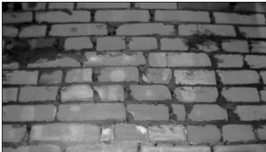
Рис. 3.13. Стандартная кирпичная кладка в один кирпич (ширина в полкирпича)
