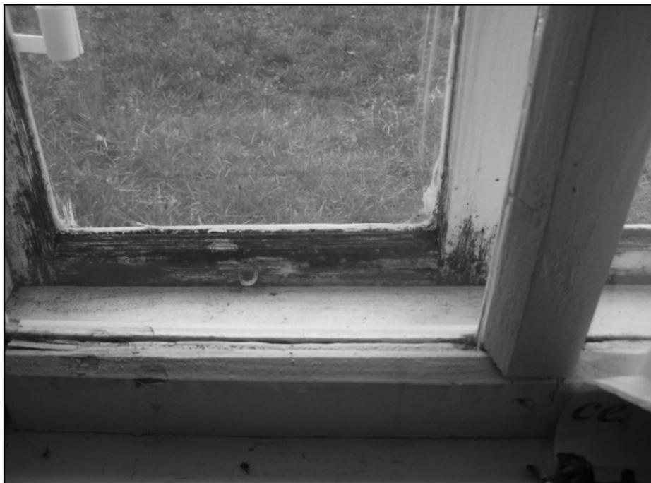
Рис. 3.7. Поражение оконных рам микроорганизмами
