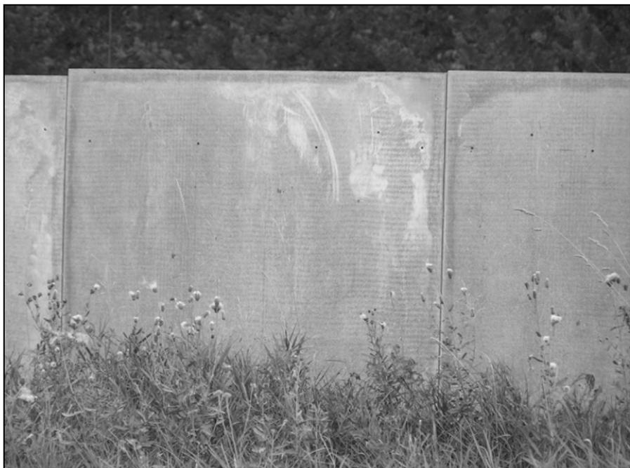
Рис. 3.2. Фрагмент забора из цементно-древесных блоков
