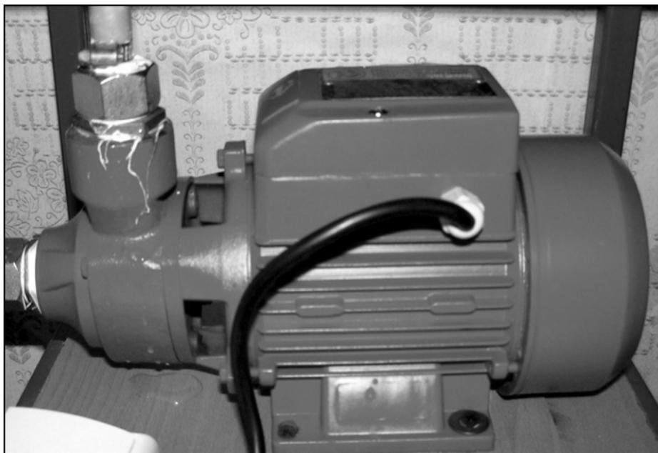
Рис. 3.16. Подключенный центробежный насос марки НБЦ-0,37
