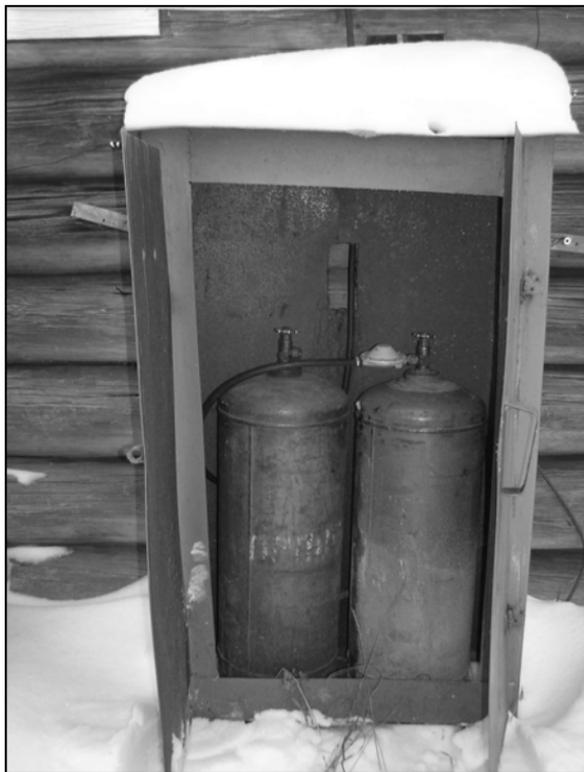
Рис. 1.3. «Внутренности» газового ящика
