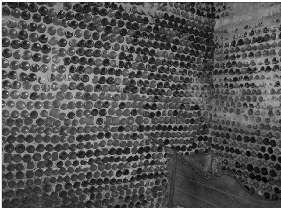
Рис. 3.10. Стены хозпостроек разумно сделать из пустых бутылок
