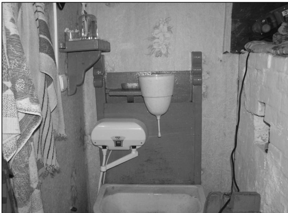
Рис. 1.7. Вариант установки водонагревателя «Polaris Omega-5» на вертикальную плоскость (стену) в месте умывания
