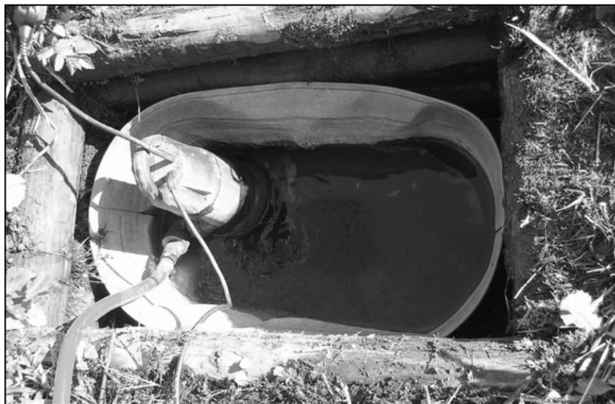
Рис. 1.6. Корыто внутри опалубки и насос НПЦ-750/5НК
