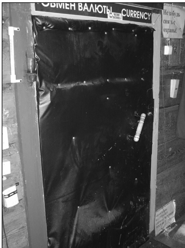
Рис. 2.28. Обитая дерматином деревянная дверь
