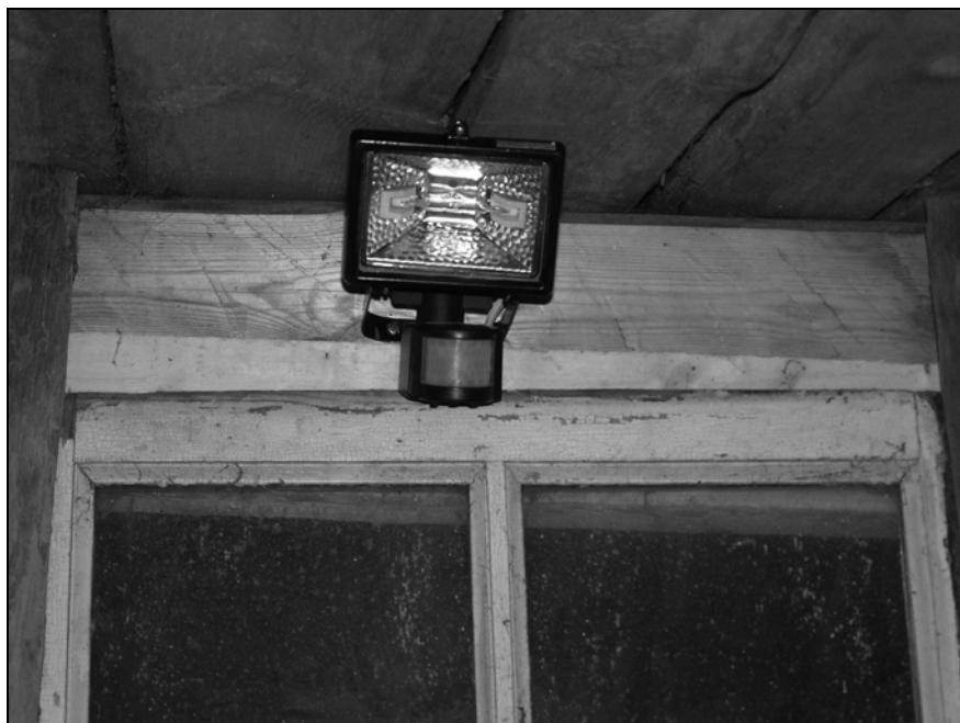
Рис. 4.19. Датчик движения, совмещенный с фонарем
