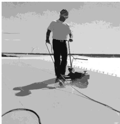
Рис. 7.3. Укладка мембраны ПЛАСТФОИЛ®(PF)
