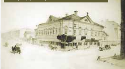
Дом Путятина на углу улиц Итальянской и Надежинской (ныне — ул. Маяковского) в сторону ул. Кирочной
