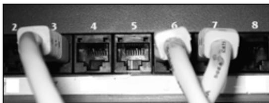
**Рис. 5.18.** Нумерация на патч-панели
