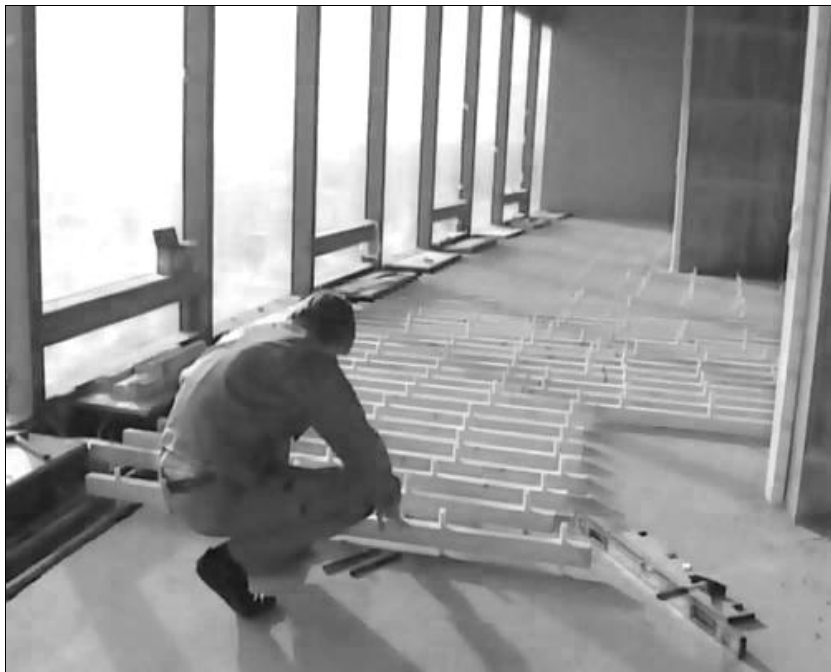
Рис. 2.9. Установка регулируемых лаг
