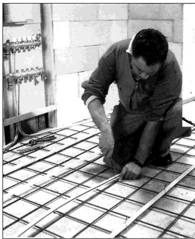
Рис. 9.1. Укладка и крепление трубы к стальной арматуре
