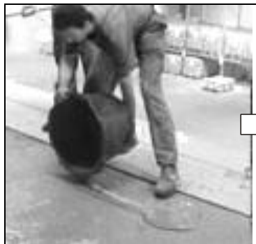
Нанесение препарата BAUBOND
