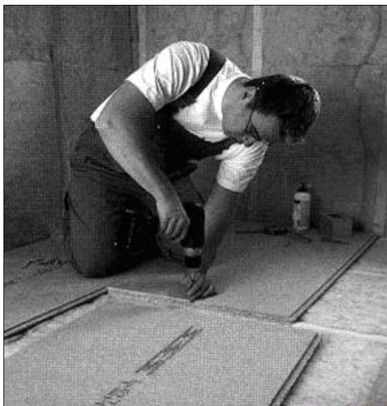
Рис. 2.8. Крепление плит
