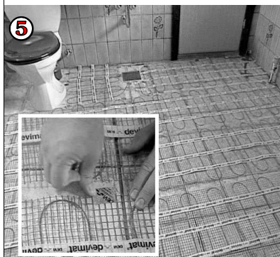
Рис. 9.3. Технология укладки Девимат
