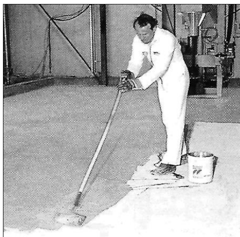
Рис. 5.2. Нанесение эпоксидного покрытия
