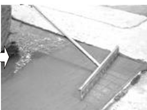
Разравнивание препарата BAUFLOOR
