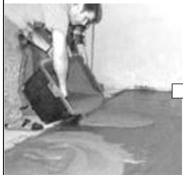
Нанесение препарата BAUFLOOR
