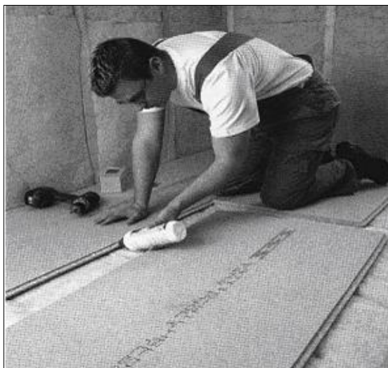
Рис. 2.7. Установка плит склеиванием по шпунтам
