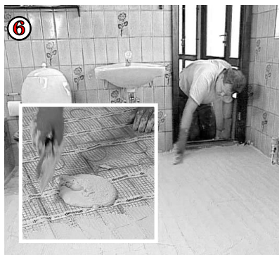
Рис. 9.3. Технология укладки Девимат
