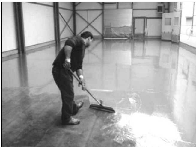
Рис. 5.5. Заливка композиции Эспол
