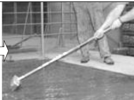
Разравнивание препарата BAUBOND
