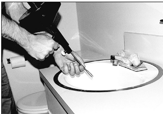
Рис. 6.31, а. Кончик троса ручной спиральной прочистки следует вытащить из корпуса и вставить в слив. Сначала снимите пружинный клапан
