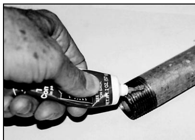
Рис. 5.30. Применяйте герметик в виде пасты или карандаша. Нанесите его по всей окружности резьбы
