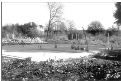
Рис. 1.3. Водопроводные и сливные трубы при последующем монтаже обрезают.
