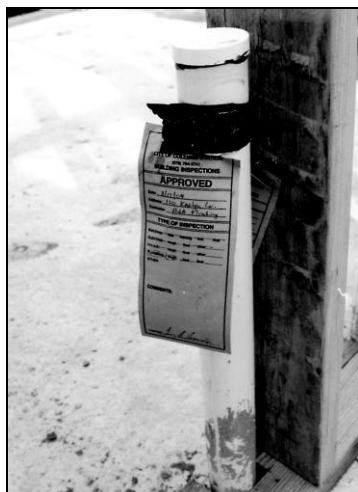
Рис. 2.2. После принятия первого этапа сантехнических работ на месте проведения работ вешается бирка
