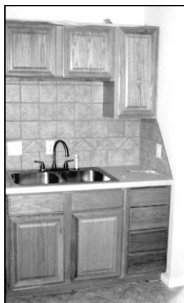
Рис. 7.3, в. Установленная мойка
