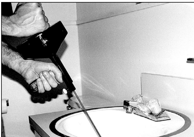
Рис. 6.31, б. Протолкните трос как можно дальше, затем поверните вертушку, чтобы завращался спиральный трос, и прочистите трубу
