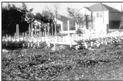
Рис. 1.3. Водопроводные и сливные трубы при последующем монтаже обрезают.
