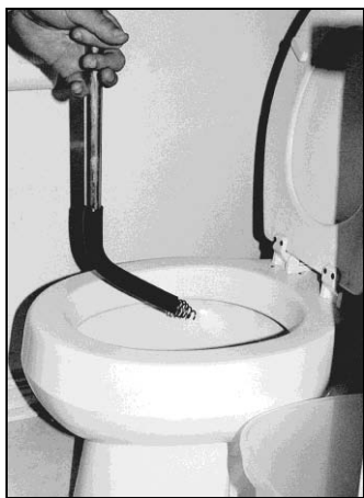
Рис. 6.32. Вытащите конец троса для прочистки канализации туалета через пластиковый рукав ( а ); поместите трос в отверстие унитаза и протолкните его как можно дальше. Затем поверните рукоятку троса для прочистки засора ( б )
