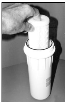
Рис. 7.55. Для замены фильтрующего элемента отвинтите картридж фильтра и вытащите старый фильтрующий элемент. Затем вставьте новый фильтрующий элемент и затяните
