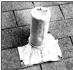
Рис. 3.9. Свинцовая втулка устанавливается поверх вентиляционной трубы для уплотнения вентиляционного отверстия
