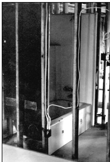
Рис. 7.27. Устанавливаются и крепятся специальные комплекты "ванна-душ" (а); эта душевая кабина сделана из стекловолокна, при этом облицовка и пароизоляция стен не требуется (б)
