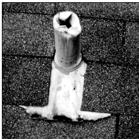
Рис. 2.11. Вентиляционная труба сточной системы, проходящая через крышу
