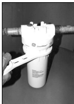
Рис. 7.55. Для замены фильтрующего элемента отвинтите картридж фильтра и вытащите старый фильтрующий элемент. Затем вставьте новый фильтрующий элемент и затяните
