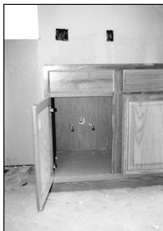
Рис. 7.3, а. Шкаф под кухонную мойку устанавливается поверх патрубков
