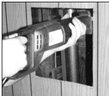
Рис. 7.1. При выполнении основных сантехнических работ вам, возможно, придется вырезать отделку существующих стен, чтобы добраться до канализационных и водопроводных труб
