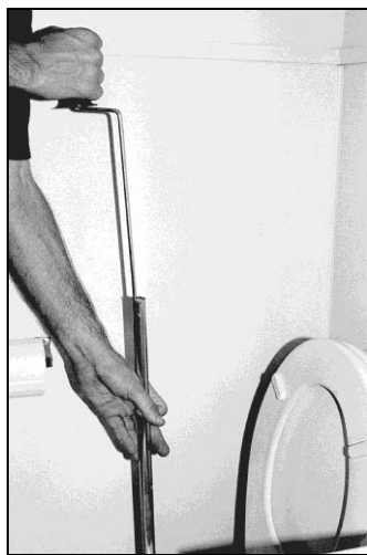
Рис. 6.32. Вытащите конец троса для прочистки канализации туалета через пластиковый рукав ( а ); поместите трос в отверстие унитаза и протолкните его как можно дальше. Затем поверните рукоятку троса для прочистки засора ( б )
