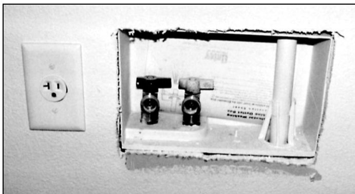
Рис. 7.49. Стандартная подготовка для установки стиральной машины в новом доме. Краны для горячей и холодной воды, а также сливная труба сосредоточены в одном корпусе. Кроме того, рядом находится электрическая розетка
