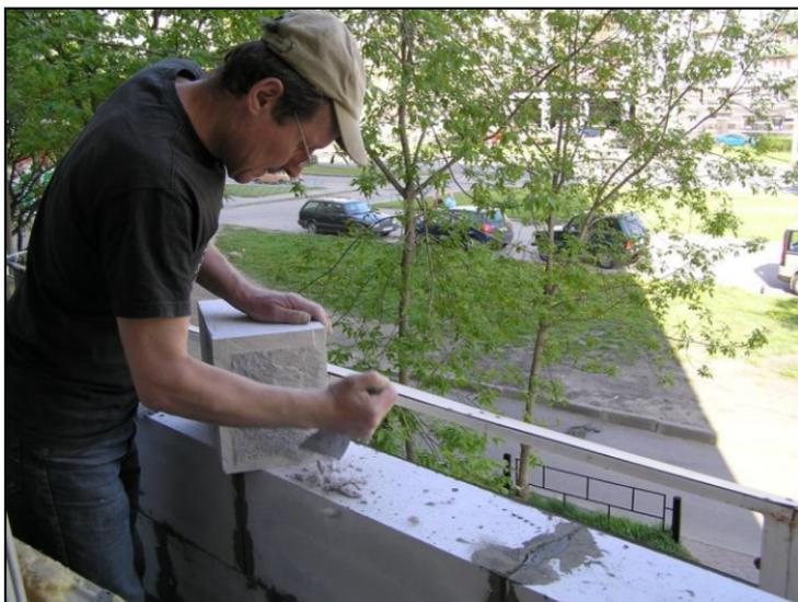
**Рис. 2.28.** Зачистка торца обрезанного газобетонного блока перед постановкой в кладку
