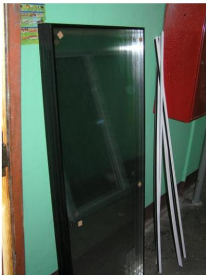
**Рис. 2.37.** Вид на лестничной клетке на снятые стеклопакеты и рядом с ними — на спейсеры, перед заносом их в квартиру со стороны лестничной клетки
