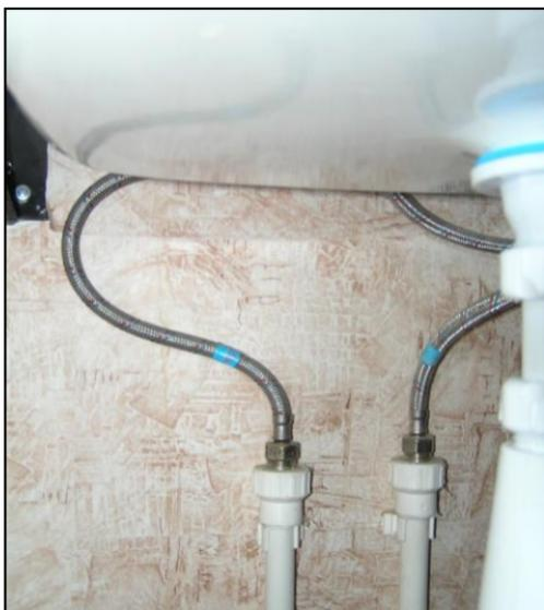
**Рис. 1.16.** Подводка горячего и холодного водоснабжения к смесителю
