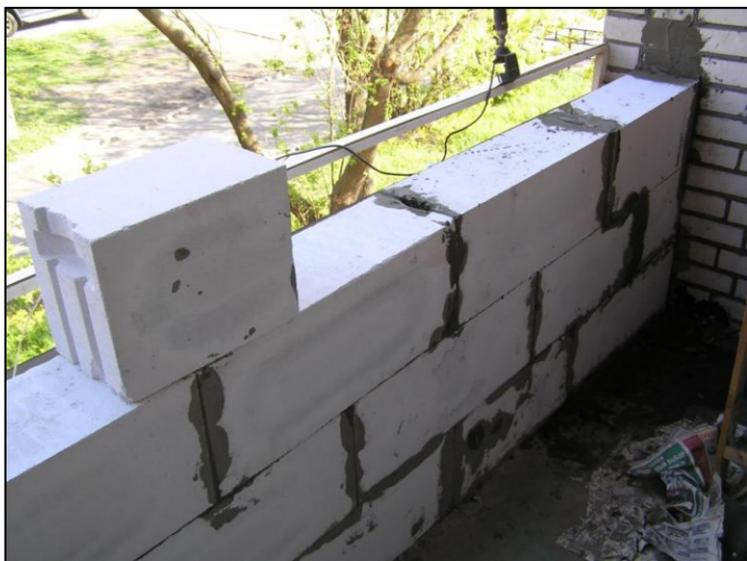
**Рис. 2.29.** Вид на обрезанный и зачищенный газобетонный блок
