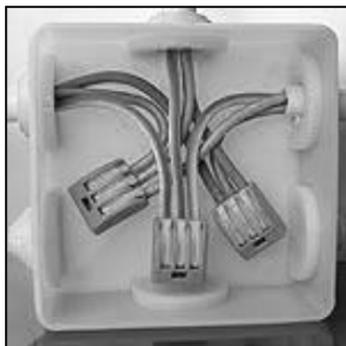
**Рис. 3.15.** Электрические провода с клеммами в распределительной коробке
