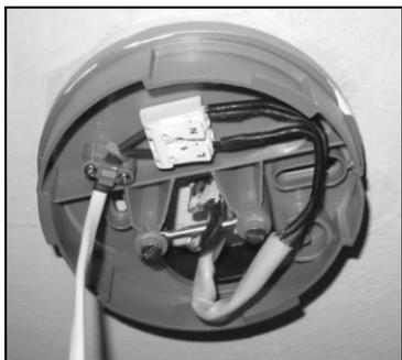
**Рис. 3.90.** Соединение электрических проводов с помощью спаренной клеммной колодки
