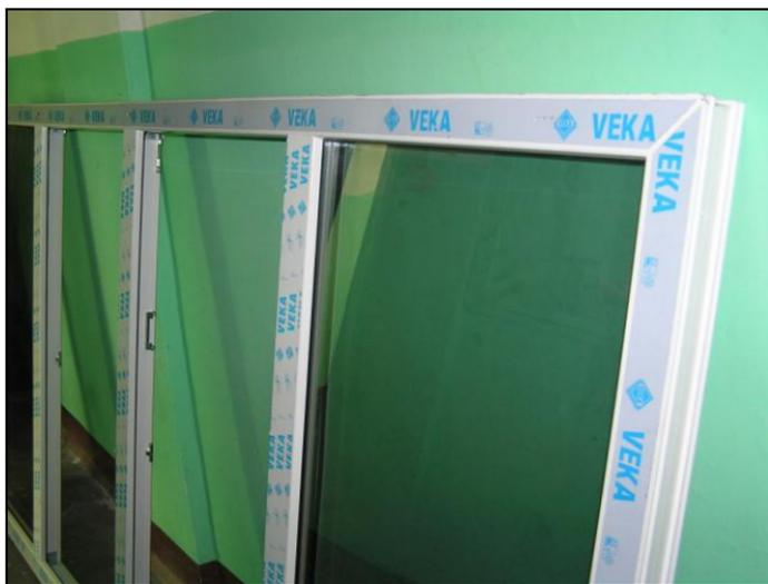
**Рис. 2.34.** Рама со стеклопакетами, занесенная на этаж перед входом в квартиру
