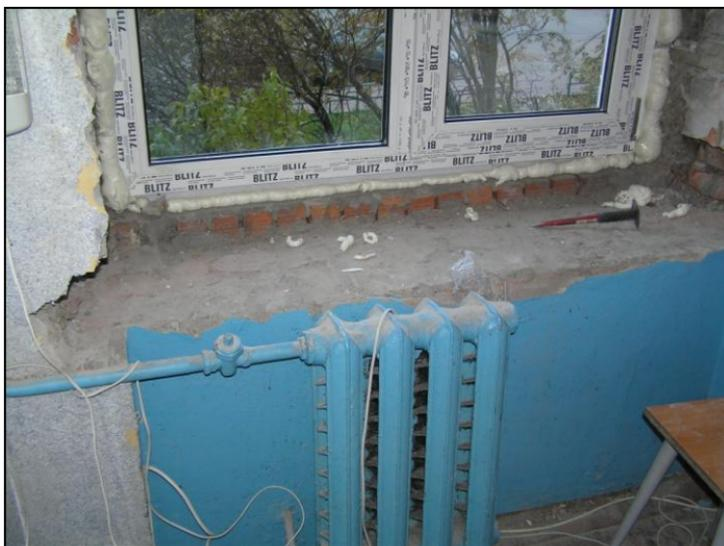
**Рис. 2.13.** Установленные рамы и запененные ниши;
