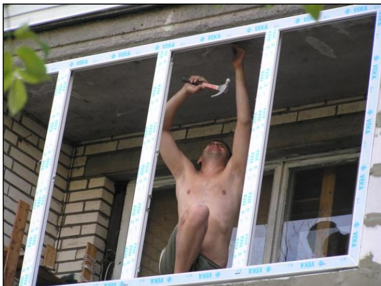
**Рис. 2.42.** Закрепление рамы с помощью шурупов и молотка
