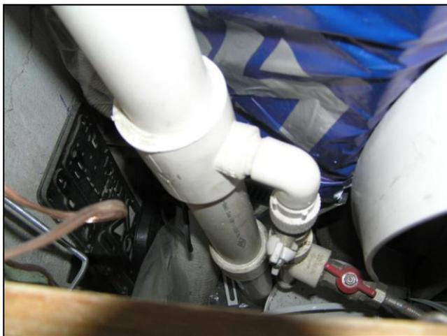
Рис. 1.13. Отвод от полипропиленовой трубы стояка
