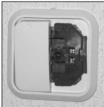
**Рис. 3.76.** Выключатель с одной установленной клавишей
