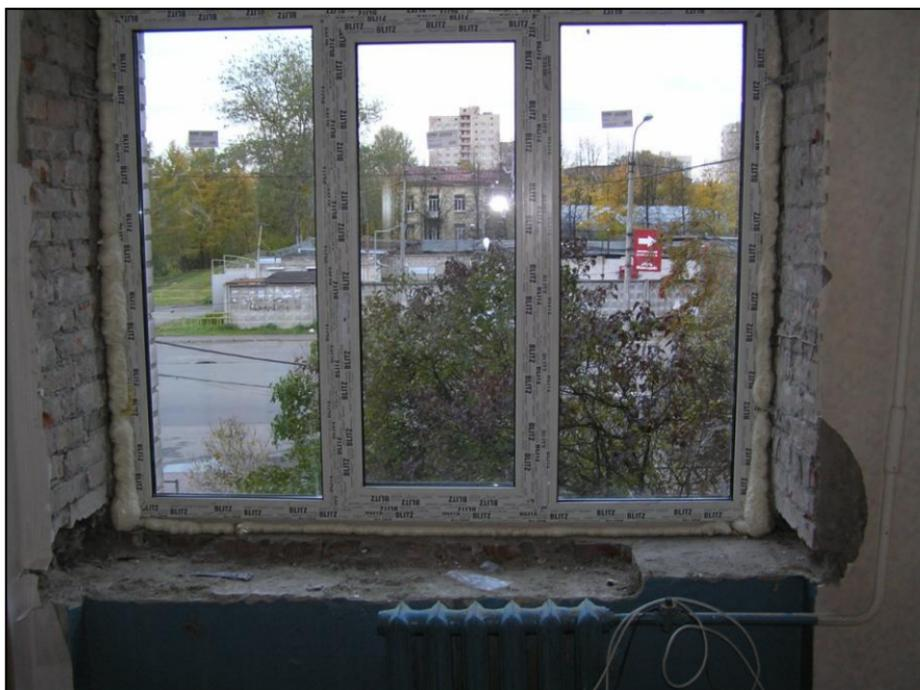
**Рис. 2.10.** Вид комнаты после демонтажа старых рам и установки нового окна
