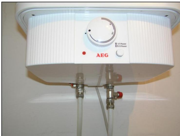
**Рис. 1.17.** Подключение подводки от полипропиленовых труб (входной и сливной контуры) к накопительному водонагревателю (бойлеру)
