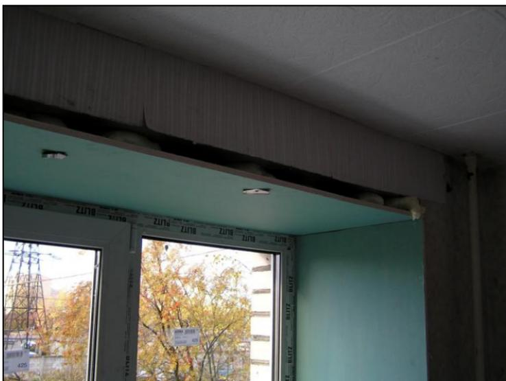
**Рис. 2.14.** Установка откосов в оконную нишу
