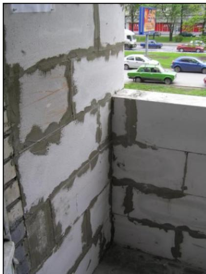
**Рис. 2.31.** Стык самонесущей стены и вертикальной перегородки на лоджии
