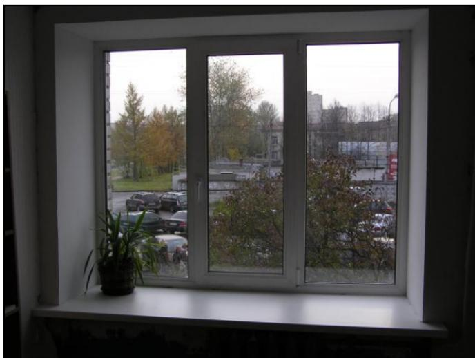
Рис. 2.22. Законченный вид окна с установленными стеклопакетами
