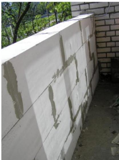
**Рис. 2.30.** Готовая самонесущая стенка из газобетонных блоков на лоджии
