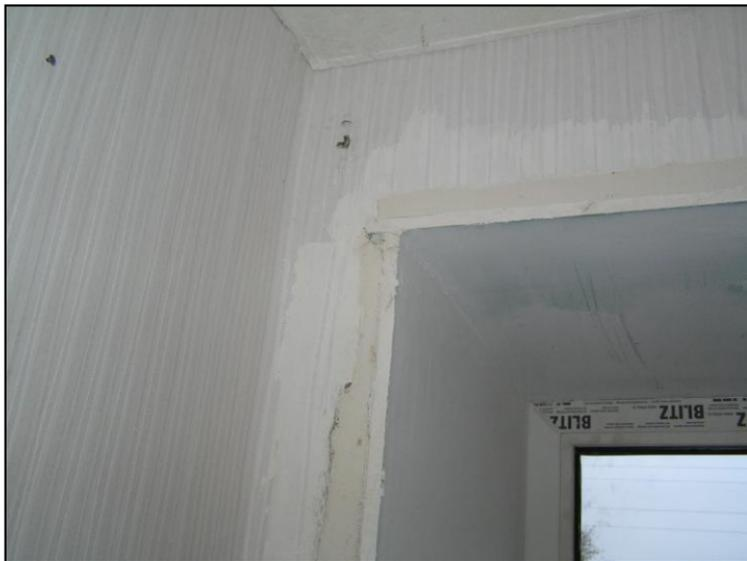
**Рис. 2.18.** Вид после цементирования и оштукатуривания откосов
