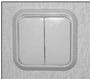
**Рис. 3.71.** Внешний вид установленного в стене клавишного выключателя освещения
