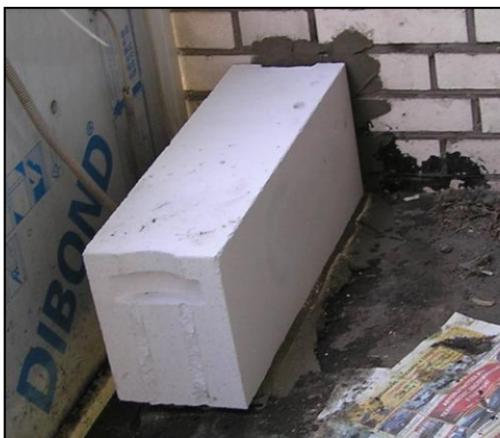
**Рис. 2.3.** Установка первого (торцевого) газобетонного блока в стык к стенке
