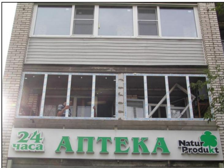
Рис. 2.45. Вид с улицы на установленные рамы (без стеклопакетов)
