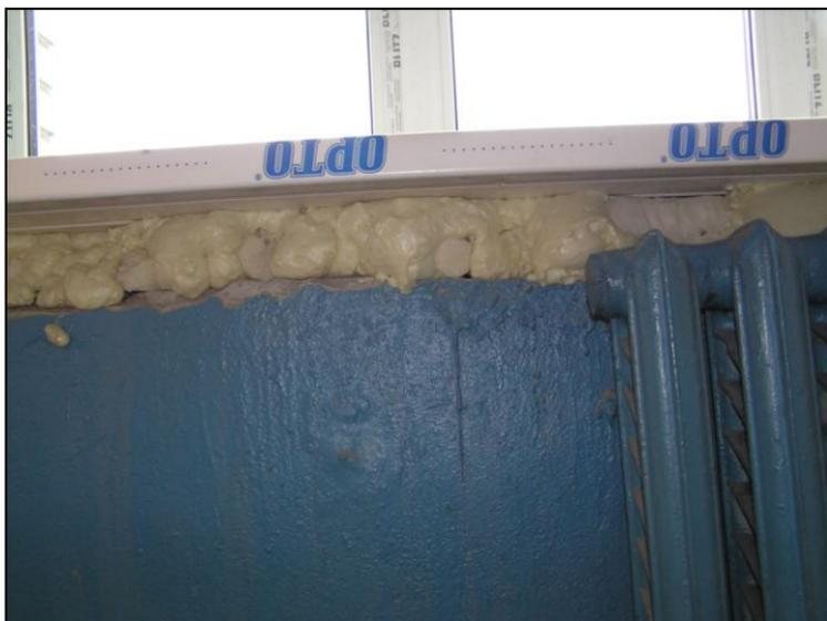
**Рис. 2.15.** Установленный подоконник и "запененная" ниша под ним
