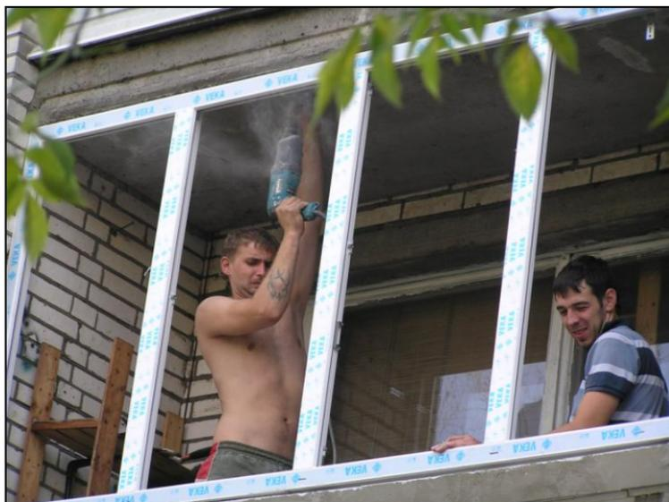
**Рис. 2.41.** Высверливание отверстий в несущих конструкциях для последующего крепления рамы стеклопакетов
