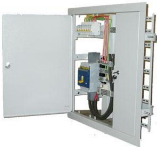
**Рис. 3.5.** Внешний вид открытого электрощитка (шкафа) с расположенными внутри выключателями-автоматами
