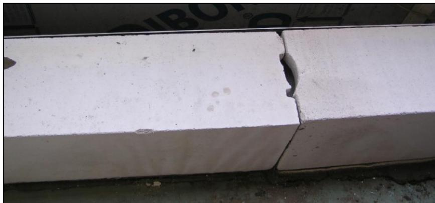
**Рис. 2.4.** Установка (по нити) газобетонных блоков стык в стык
