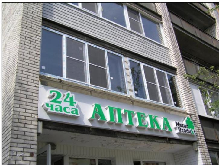
**Рис. 2.46.** Окончательный вид с улицы на лоджию с установленными рамами и стеклопакетами
