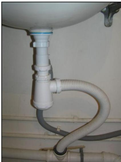
**Рис. 1.21.** Вариант слива от стиральной машины с помощью соединения с сифонной системой
