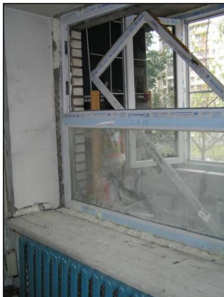
**Рис. 2.24.** Оригинальный (горизонтальный) метод установки стеклопакета в комнате
