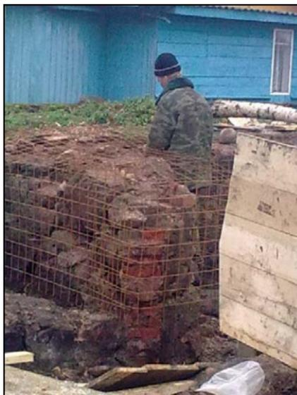
**Рис. 2.50.** Обтяжка старого каменного фундамента арматурной сеткой по всему периметру
