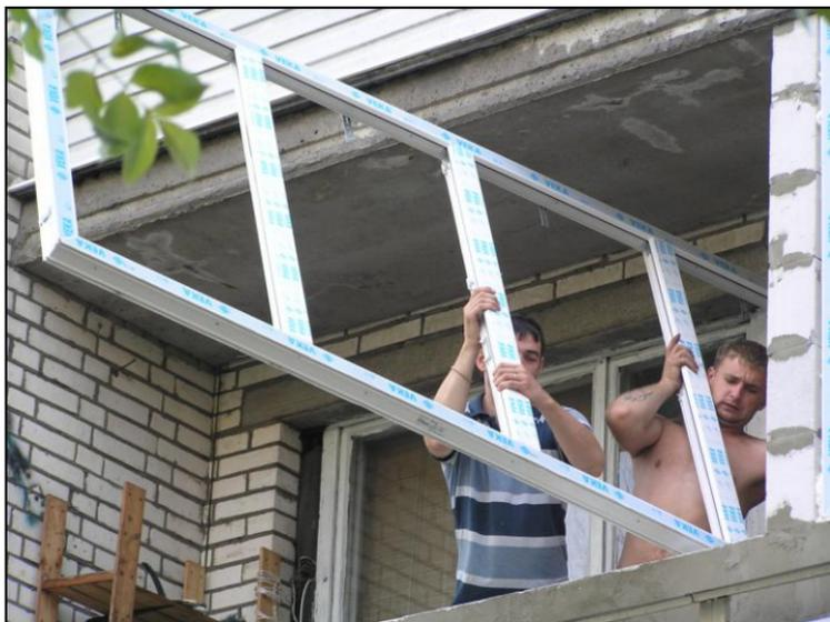
**Рис. 2.35.** Занос рамы без стеклопакетов силами двух человек через балконную дверь 2×0,8 м
