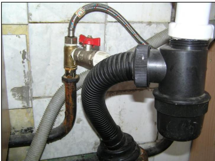
**Рис. 1.19.** Подключение подводки (холодная вода) к стиральной машине
