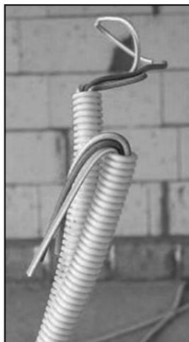
**Рис. 3.13.** Проводка кабеля в ПВХ-трубах
