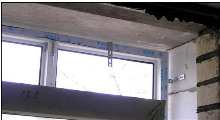
**Рис. 2.43.** Вид на закрепленную раму со стороны комнаты
