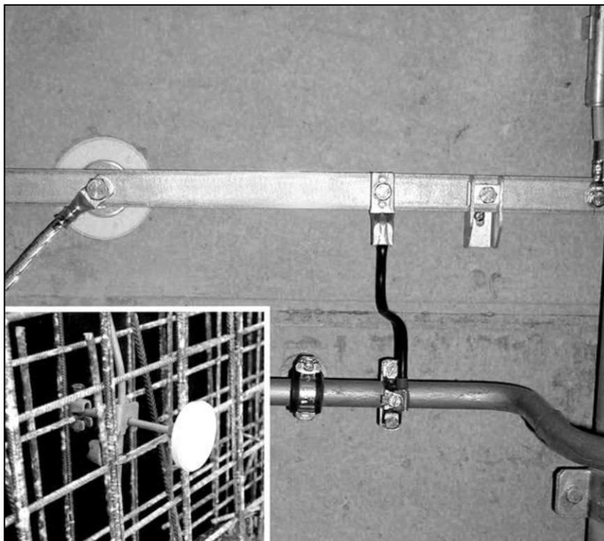
Рис. 3.48. Пример надежного заземления
