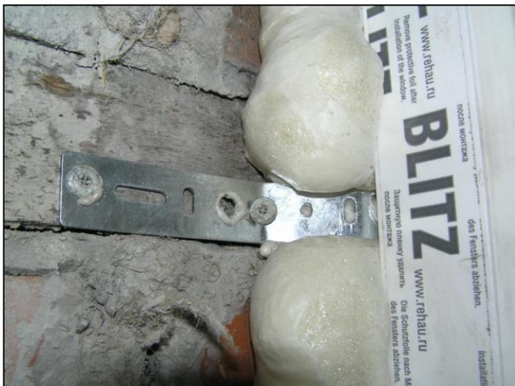
Рис. 2.12. Метод крепления уголков по периметру откосов оконной ниши
