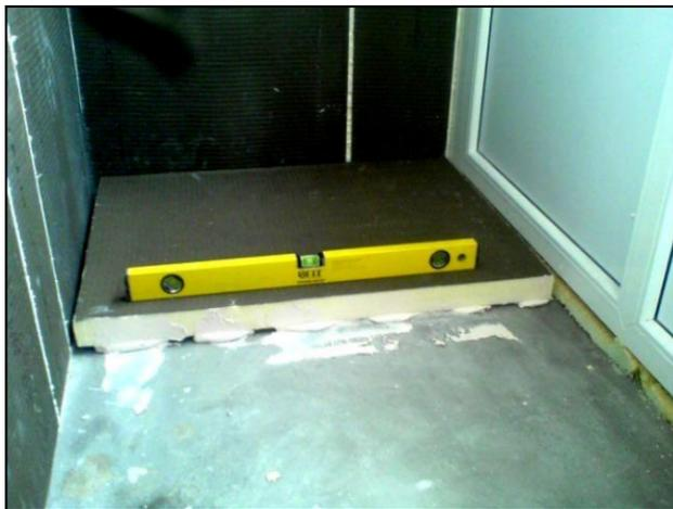
**Рис. 2.9.** Строительная плита-утеплитель Wedi
