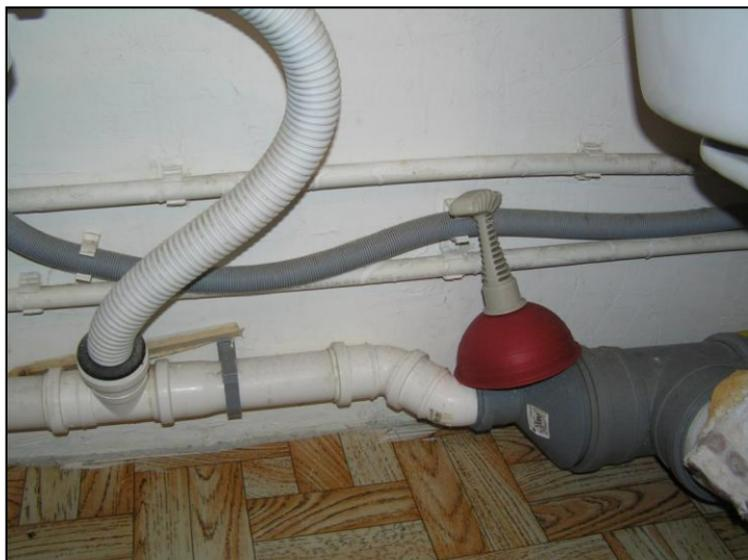
Рис. 1.24. Организация слива непосредственно в фановую трубу
