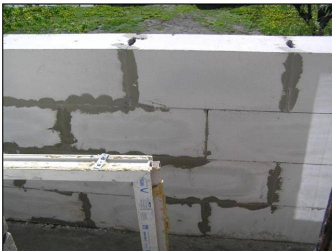
**Рис. 2.5.** Готовая самонесущая стенка из газобетонных блоков
