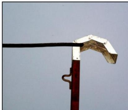
**Рис. 3.88.** Способ проводки кабеля и его заведение к потребителю электроэнергии под углом 90°
