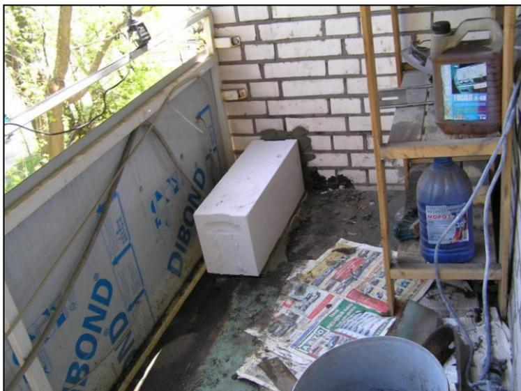
Рис. 2.26. Установка первого (торцевого) газобетонного блока в углу лоджии
