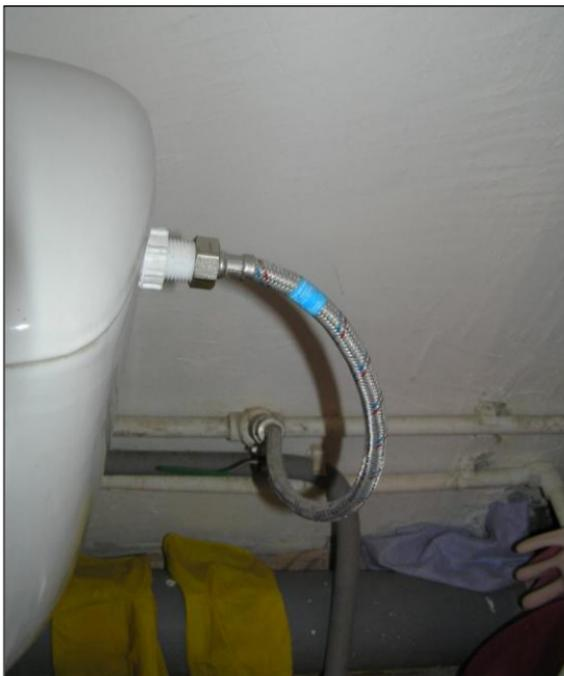
**Рис. 1.15.** Подводка холодной воды к бачку унитаза "Компакт"
