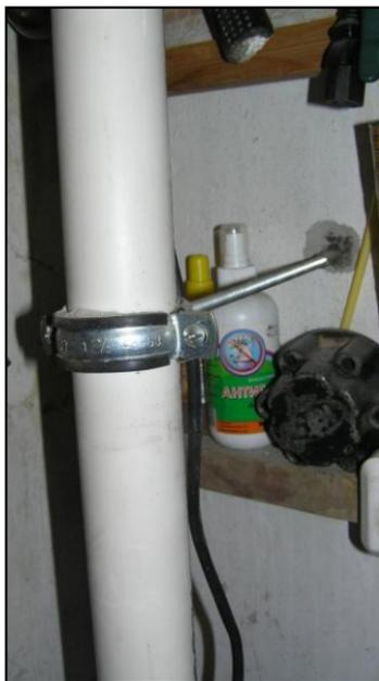
**Рис. 1.14.** Муфта крепления трубы стояка к стене
