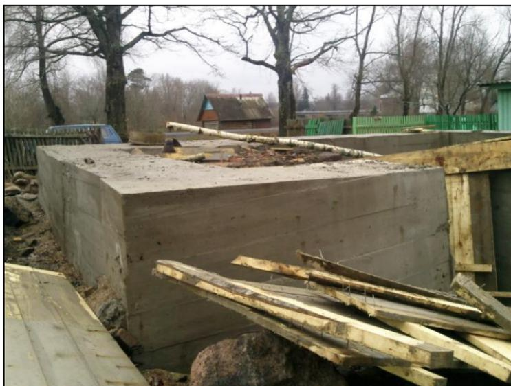
**Рис. 2.52.** Участок цементного фундамента после снятия деревянной опалубки
