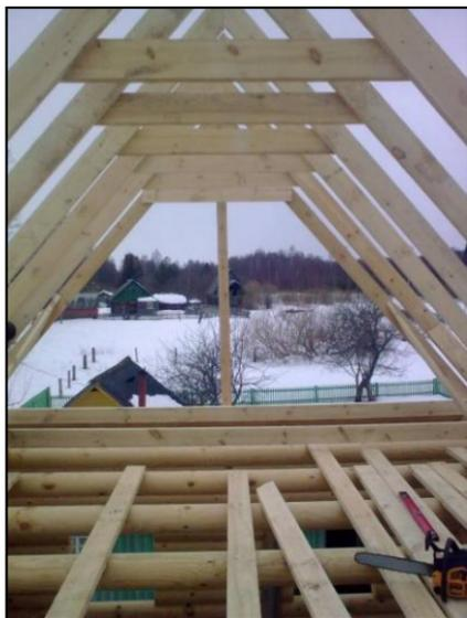
**Рис. 2.57.** Строительство крыши
