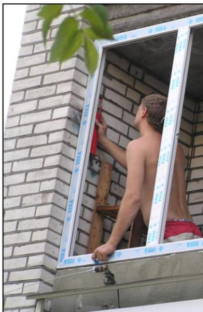
**Рис. 2.38.** Применение строительного уровня для контроля установки рамы на лоджии
