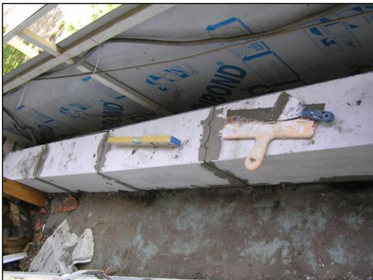
**Рис. 2.27.** Установка (по нити) газобетонных блоков стык в стык и инструментарий для работ
