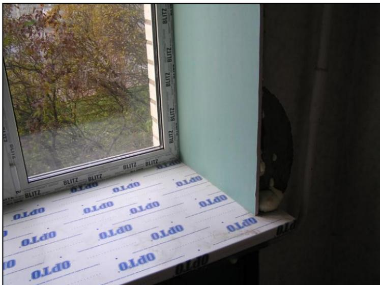
**Рис. 2.17.** Вид окна после установки и запенивания откосов
