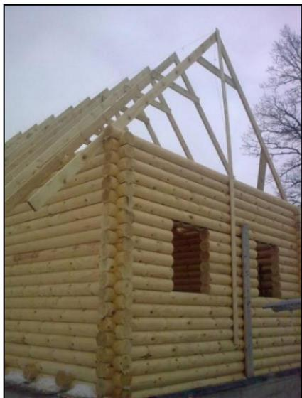
**Рис. 2.56.** Установленный на шипы сруб
