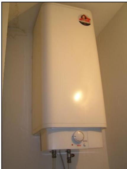
**Рис. 1.18.** Бойлер фирмы AEG объемом 100 л накопительного типа для автономного обеспечения горячей водой
