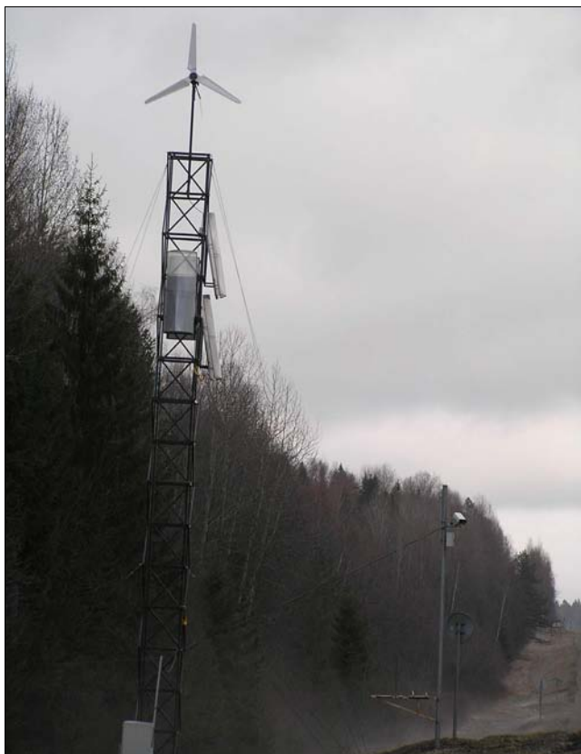
Рис. 1.2. Автономные камеры вдоль дорог. Питание от ветрогенератора
